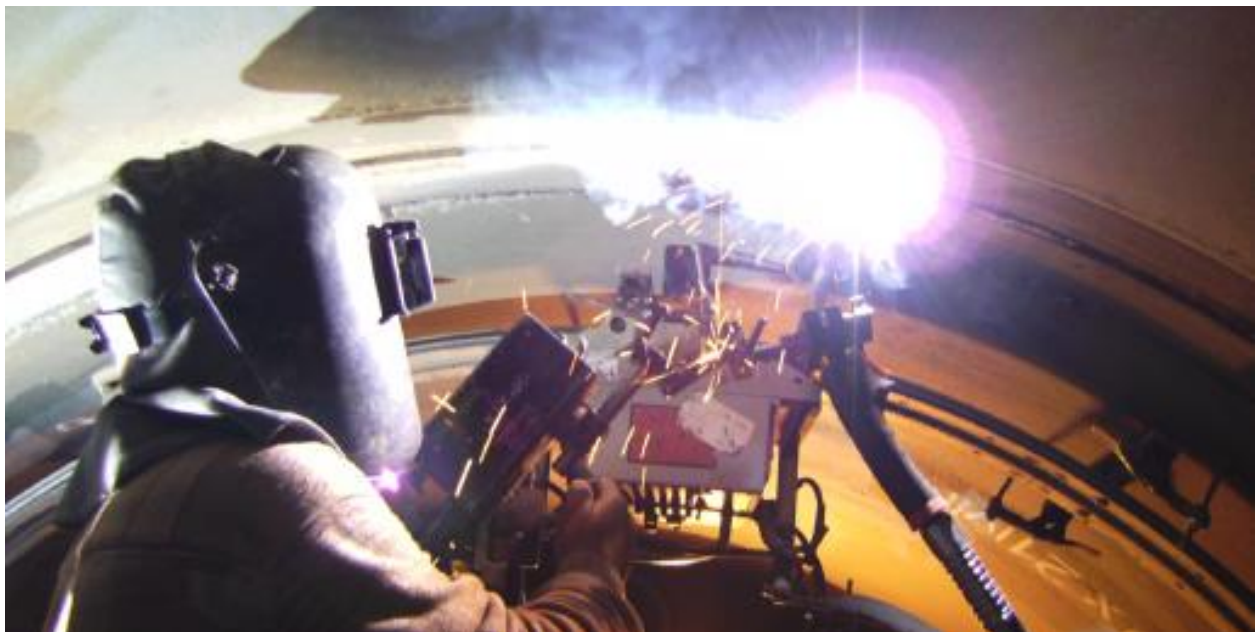
EQUIPOS DE SOLDADURA PARA VIROLA Y TANQUES
